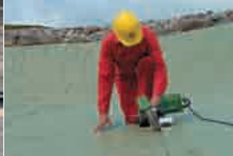
ТВИННИ Т с комбинированным клином при сварке геомембраны из ПЭНД.
