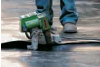
ТВИННИ Т с комбинированным клином при сварке геомембраны из ПЭНД.
