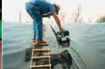
При использовании автомата АСТРО получаются сварные швы наивысшего качества при работе на самой высокой скорости - 5 м/мин.
